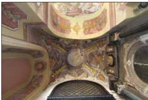
23. Lublin, archikatedra, sklepienie jednego z przęseł nawy bocznej, stan po pracach konserwatorskich, fot. P. Maciuk, 2007.
