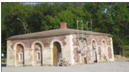
39. Zamość, Wartowania przy Bramie Szczebrzeskiej, stan w trakcie prac remontowych, fot. W. Koman, 2009.
