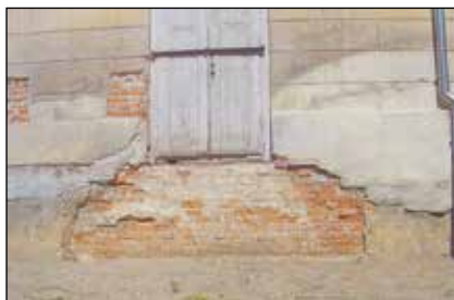
12. Elewacja wschodnia, wtórnie wykonany otwór drzwiowy w miejscu blendy, fot. Ł. Rejniewicz, 2008.
