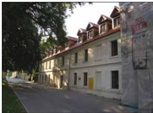
37. Zamość, d. zespół kościoła i klasztoru klarysek, skrzydło klasztorne, stan w trakcie prac remontowych, fot. W. Koman, 2009.
