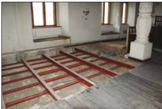
31. Kazimierz Dolny, kamienica po Św. Krzysztofem, wzmocnienie stropu, stan w trakcie prac remontowych, fot. D. Kopciowski, 2008.
