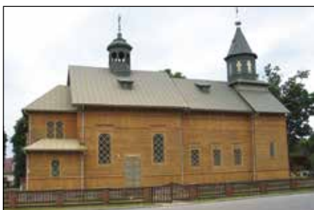
34. Majdan Stary, kościół parafialny, stan w trakcie prac remontowych, fot. W. Koman, 2009.
