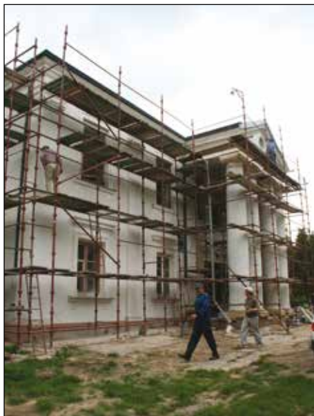
42. Białka, Pałac w trakcie prac remontowych, fot. J. Maraśkiewicz, 2008.
