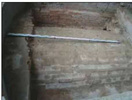
fot. 34. Zamość – fortyfikacje. Sklepienie poterny w kurtynie III-IV, fot. A. Witkowski
