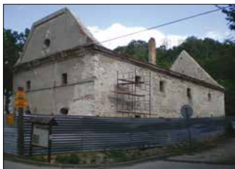
15. Kazimierz Dolny, spichlerz Bliźniak, stan w trakcie prac remontowych, fot. M. Kurczewicz, październik 2008.
