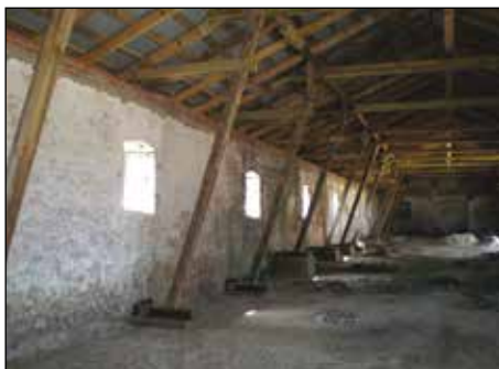
14. Potoczek, d. obora, wieżba dachowa, stan po remoncie, fot. M. Kurczewicz, kwiecień 2009.
