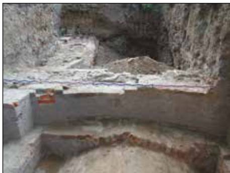
fot. 32. Zamość – fortyfikacje. Fragment galerii strzelniczej i sklepienie poterny w kurtynie III-IV, fot. A. Witkowski
