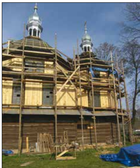
50. Chłopiatyń, kościół filialny (d. cerkiew gr.-kat.), stan w trakcie remontu, fot. L. Kuśmierz, 2008.
