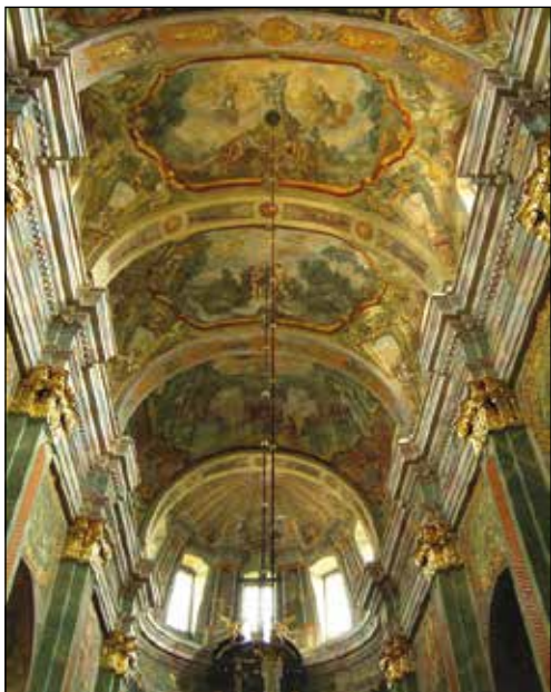
1. Archikatedra Lubelska, sklepienie nawy głównej pokryte freskami Józefa Meyera, po pracach konserwatorskich, fot. P. Maciuk 2008.
