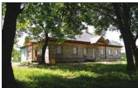
46. Wołkresnice Duże, Dwór w trakcie prac remontowych, fot. J. Maraśkiewicz, 2008.
