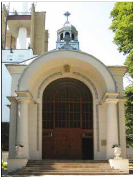
20. Lublin, ul. Biała, kaplica na d. cmentarzu wojennym, widok ogólny, stan po remoncie, fot. D. Kopciowski, 2008.
