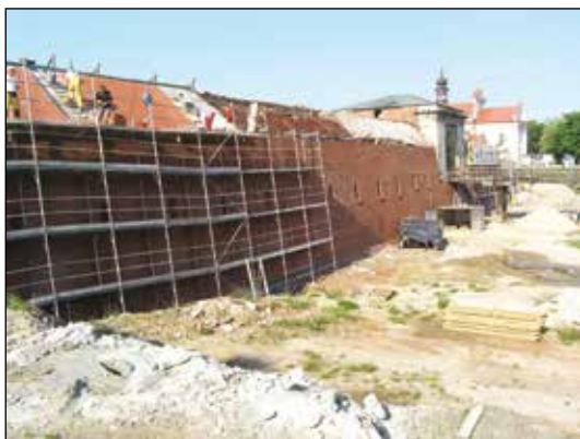
32. Zamość, Brama Lubelska Nowa z galerią strzelniczą, stan w trakcie prac remontowych, fot. W. Koman, 2009.
