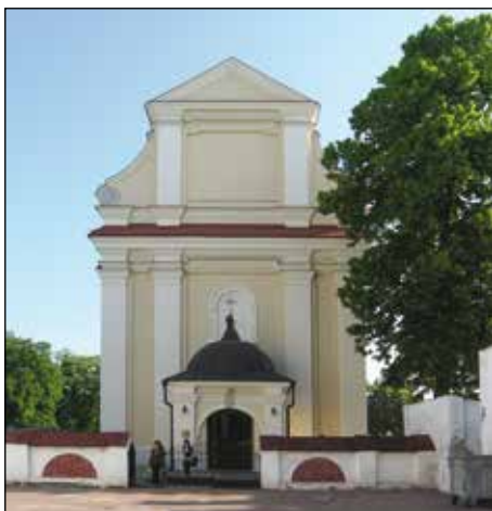
40. Zamość, Kościół pod wezw. Św. Katarzyny, fasada, stan po remoncie, fot. W. Koman, 2009.
