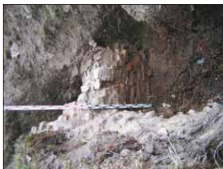
fot. 3. Czemierniki, gm. Radzyń Podlaski. Zespół rezydencjonalno-obronny. Odsłonięta dolna partia muru kurtynowego wraz z przyporą, fot. C. Hadamik 2008.
