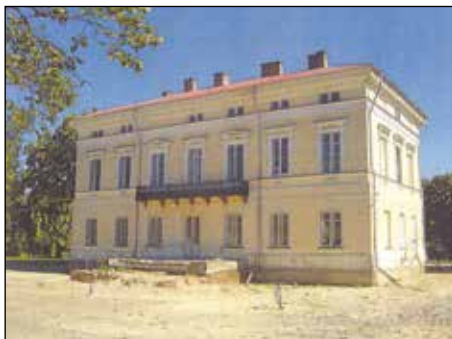
2. Elewacja tylna (płd.), stan po niwelacji terenu i badaniach architektonicznych w 2008 roku, fot. Ł. Rejniewicz.
