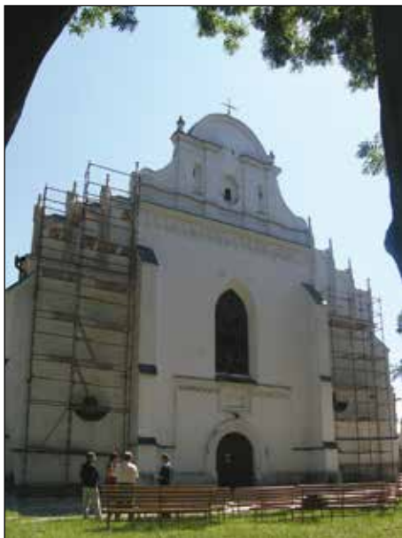
2. Kraśnik, d. kościół klasztorny kanoników regularnych, ob. kościół parafialny pod wezw. NMP i Św. Augustyna, stan w trakcie prac remontowych, fot. B. Stolarz, wrzesień 2008.
