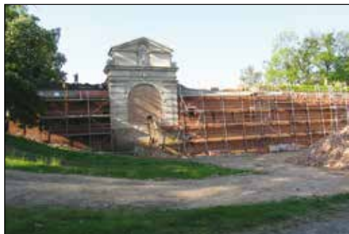
38. Zamość, Brama Lubelska Stara z galerią strzelniczą, stan w trakcie prac remontowych, fot. W. Koman, 2009.
