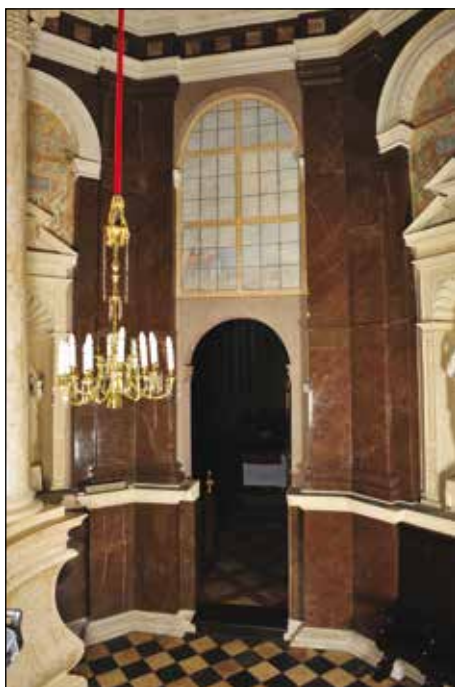
21. Lublin – archikatedra – okładziny ścian kaplicy pn. po konserwacji, fot. J. Śliwa 2008.
