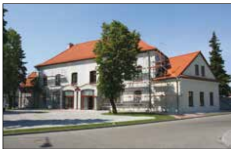
47. Biała Podlaska, Budynek Domu Strażaka w trakcie prac remontowych, fot. J. Maraśkiewicz, 2008.
