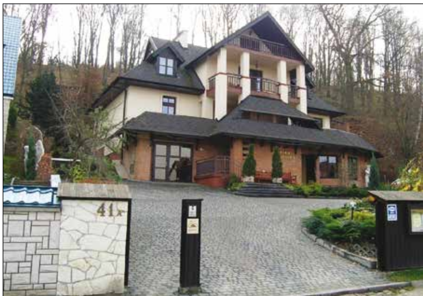
Budynek przy ul. Krakowskiej, uzgodniony w zrealizowanej formie w latach 80. XX w., fot. autor 2007
