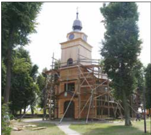
43. Polskowola, Kościół w trakcie prac remontowych, fot. J. Maraśkiewicz, 2008.
