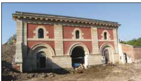
33. Zamość, Brama Szczepieńska, widok od ul. Kolegiackiej, stan w trakcie prac remontowych, fot. W. Koman, 2009.
