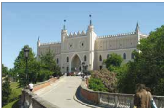
10. Lublin, Zamek ob. Muzeum Lubelskie – widok elewacji frontowej, stan po remoncie, fot. K. Rutkowski, maj 2009.
