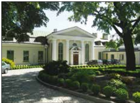
12. Lublin, ul. Wyszyńskiego 2, Pałac Biskupi, stan elewacji po remoncie, fot. K. Rutkowski, maj 2009.
