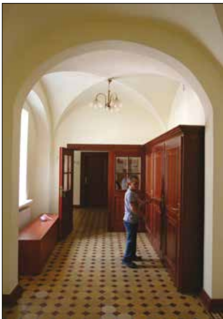
12. Biała Podlaska, dawny szpital i klasztor SS Szarytek. Korytarz skrzydła pd. (szatnia) po pracach konserwatorskich.
