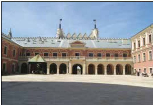
11. Lublin, Zamek ob. Muzeum Lubelskie – widok elewacji od strony dziedzińca, stan po remoncie, fot. A. Wiśniewska, lipiec 2007.
