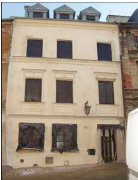
8. Lublin, ul. Grodzka 15, kamienica, stan w trakcie prac remontowych, fot. K. Rutkowski, sierpień 2008.
