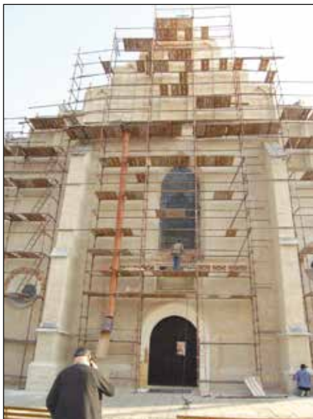
3. Kraśnik, d. kościół klasztorny kanoników regularnych, ob. kościół parafialny pod wezw. NMP i Św. Augustyna, prace remontowe – odsłonięty oryginalny wątek muru, fot. B. Stolarz, wrzesień 2008.
