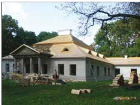
5. Krupie, dwór, stan w trakcie prac remontowych, fot. P. Wira, maj 2008.
