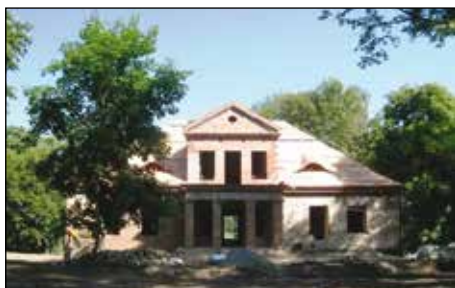
52. Dąbie, Dwór, elewacja frontowa, stan w trakcie prac remontowych, fot. J. Barański, 2009.
