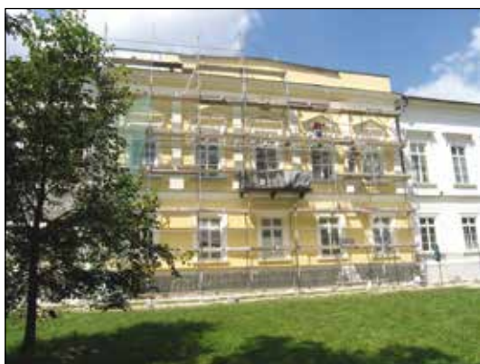
27. Puławy, pałac Czartoryskich, oficyna, stan w trakcie prac remontowych, fot. D. Kopciowski, kwiecień 2008.
