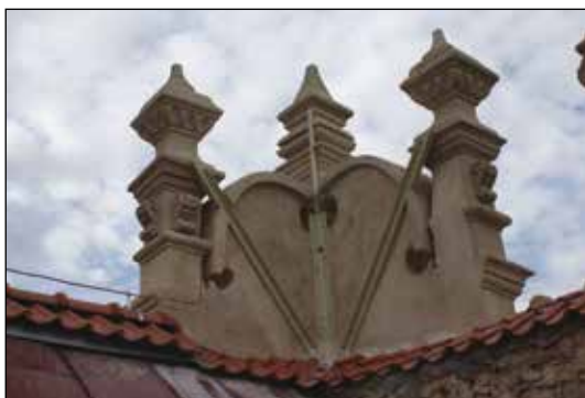
30. Kazimierz Dolny, kamienica po Św. Krzysztofem, wzmocnienie attyki, stan po remoncie, fot. D. Kopciowski, 2008.
