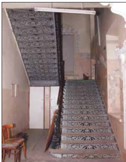
9. Żeliwna klatka schodowa, fot. R. Róg, 2007.
