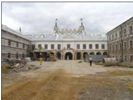
9. Lublin, Zamek ob. Muzeum Lubelskie – widok elewacji od strony dziedzińca – stan w trakcie remontu, fot. A. Wiśniewska, lipiec 2007.
