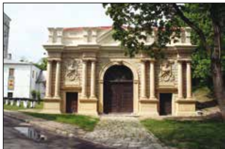
48. Biała Podlaska, Zespół zamkowy, brama wjazdowa, stan po pracach konserwatorskich, fot. J. Maraśkiewicz, 2008.
