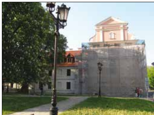
35. Zamość, d. zespół kościoła i klasztoru klarysek, stan w trakcie prac remontowych, fot. W. Koman, 2009.
