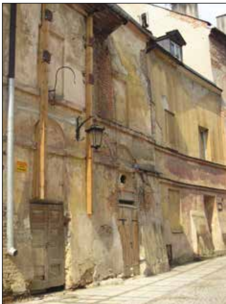
6. Lublin, Teatr Stary, ul. Jezuicka 18, widok zabezpieczonych ścian zewnętrznych, elewacja od strony ul. Dominikańskiej, fot. A. Wiśniewska, kwiecień 2009.
