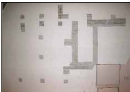
10. Klatka schodowa, poziom I piętra, odsłonięte fragmenty XVIII-wiecznej dekoracji iluzjonistycznej, fot. R. Róg, 2007.
