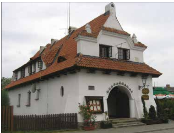
Budynek tzw. „Łaźni” wzniesiony w okresie międzywojennym przy ul. Senatorskiej, wg proj. J. Koszczyc-Witkiewicza, fot. autor, 2008.
