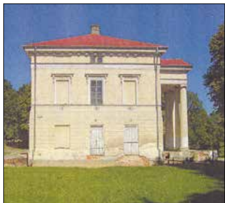
3. Elewacja wschodnia, stan po niwelacji terenu i badaniach architektonicznych w 2008 roku, fot. Ł. Rejniewicz.
