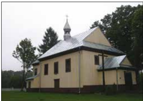
41. Płonka, kościół rzymskokatolicki, stan po remoncie, fot. B. Kruk, 2008.
